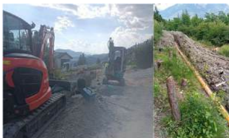
Renouvellement de réseau chemin de l'Amitié (Embrun)
