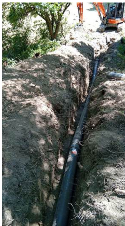
Renouvellement canalisation d'eaux usées Secteur « Caléryère » (Embrun)
