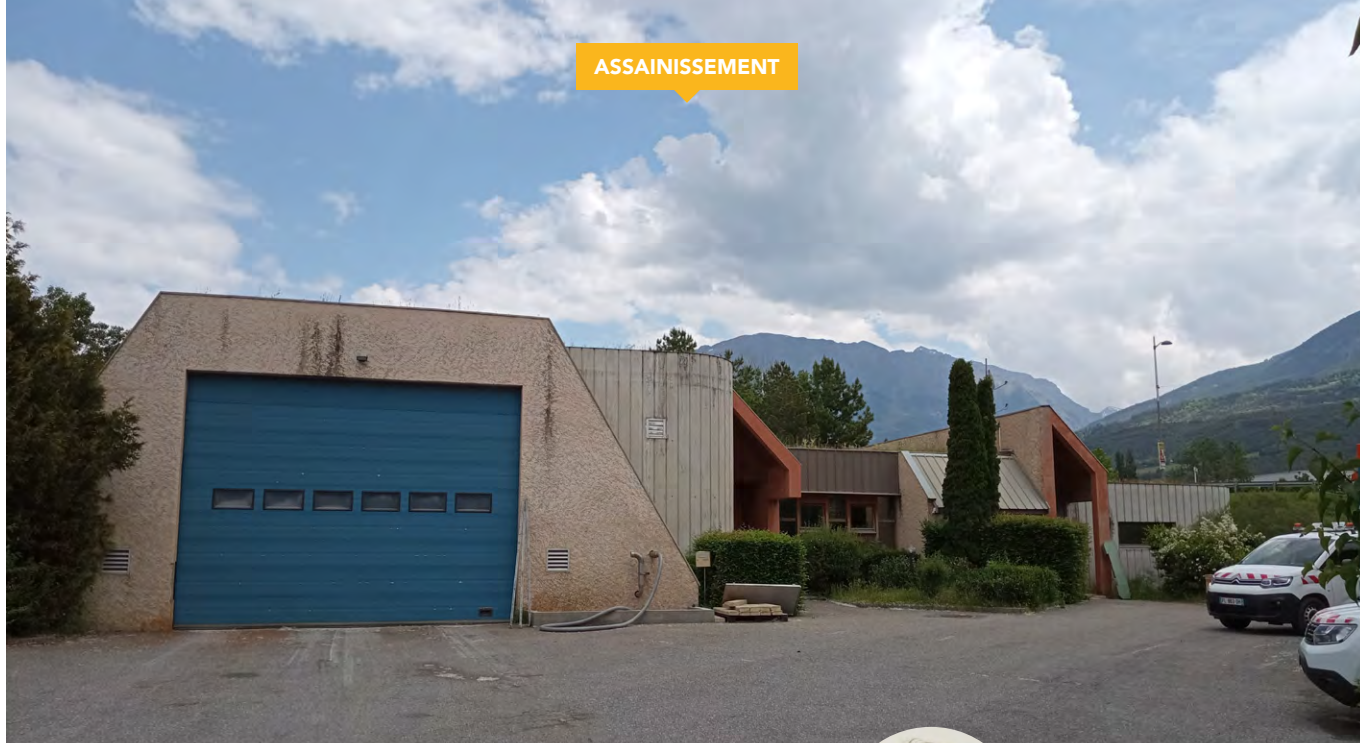
Station d'épuration Embrun
