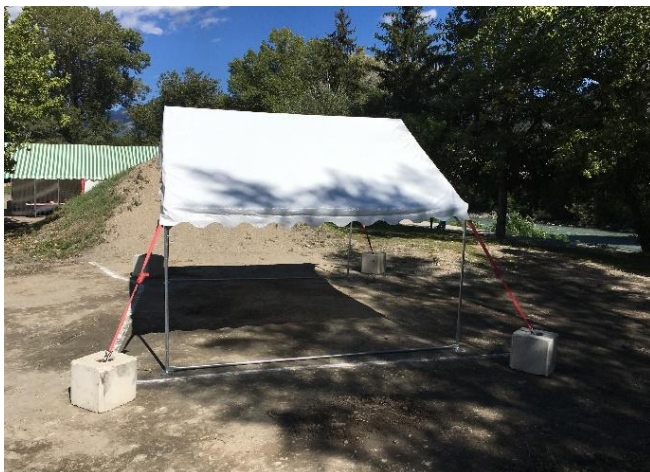
Barnums 5m x 8m avec son lestage obligatoire en béton armé de 530 kg.
