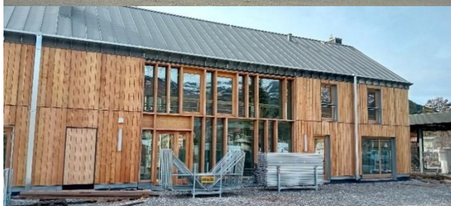
Décembre 2025 : Pose murs rideaux + bardages mélèze
