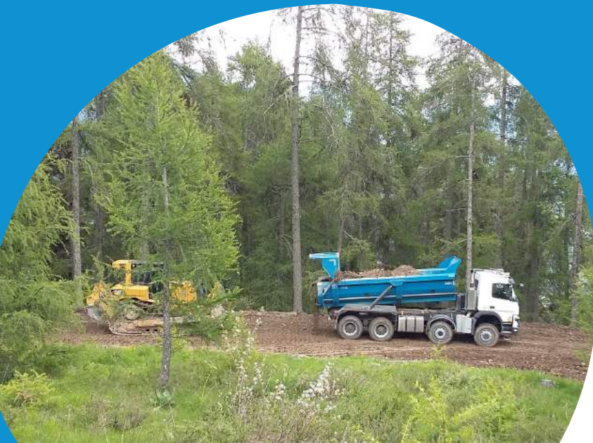
Chantier réhabilitation RF Joubelle depuis Réallon juin 2021 - Photo : L. Bobet
