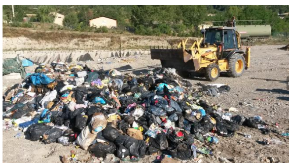
1. Déversement d'une benne
