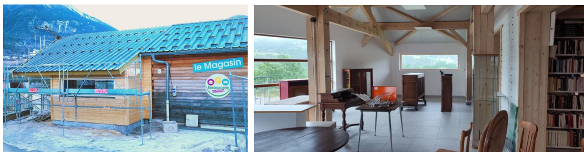
Figure 56 : Extension de la Ressourcerie
