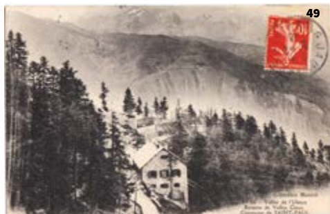
49 - Batterie de Vallon-Claus en partie construite par l'entreprise Spitalier de La Condamine, 1913 © Collection Joseph Lèbre
