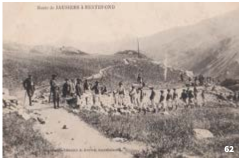
62 – Chantier de construction de la route stratégique de Restefond, début xx e siècle © Collection Joseph Lèbre
