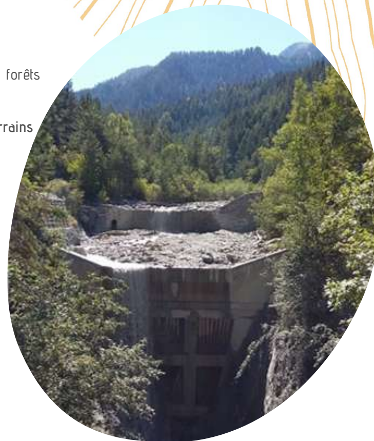
Ouvrage RTM, Crots - Photo : L. Bobet
