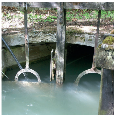
Martelière de canal à Baratier © Corinne Clivio PAH SPGQ
