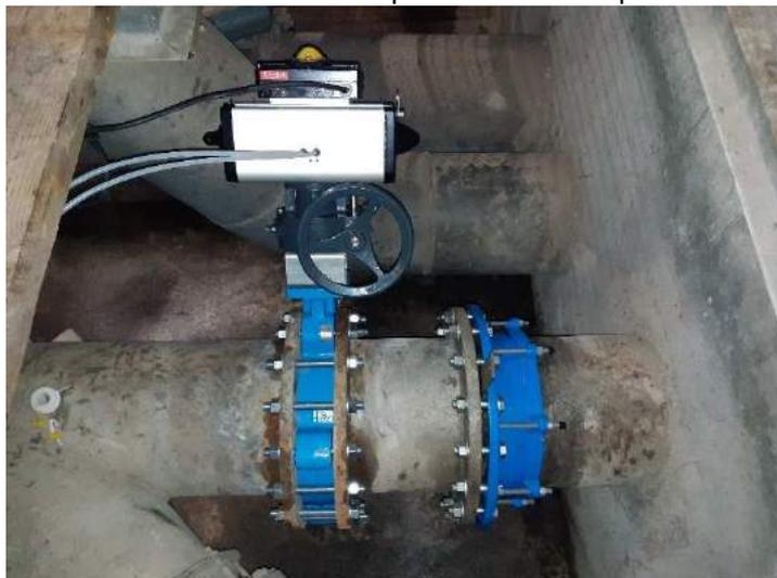
Les syphons des biocarbone qui présentait un état de corrosion avancé pouvant perturber le lavage des filtres (difficultés d'amorçage) ont été refaits à neuf.
