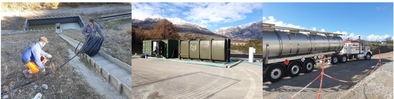
Photo 1 : pose du tuyau d'évacuation des perméats
