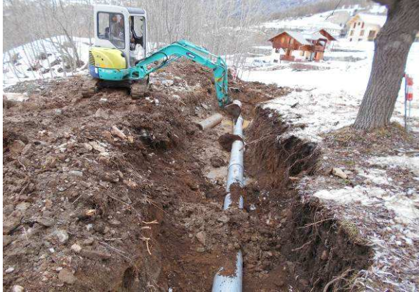
réparation de la conduite de transfert des eaux usées à « Pramouton » Les Orres
