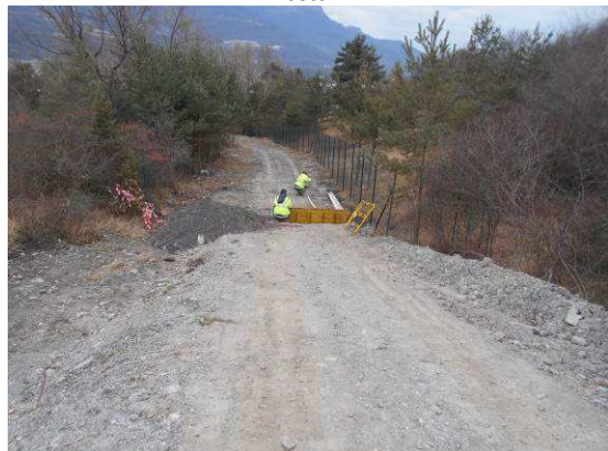
Création piste d'accès au PR de « Chadenas »
