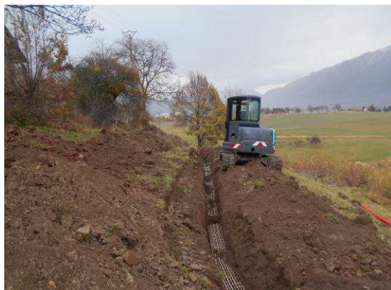
Construction du réseau à Châteauroux-les-Alpes « La Reste »
