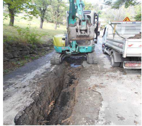
Renouveau d'une portion de réseau eaux usées à « Côte Chamois » Embrun
