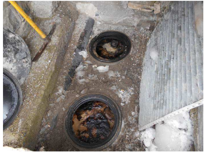
mission de contrôle d'un bac à graisses d'un établissement
