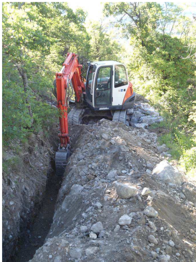
Construction du réseau à Châteauroux-les-Alpes « Le Vazet »
